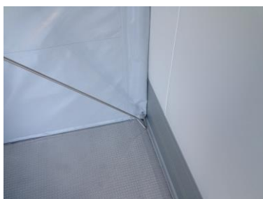
Falze der Trennwand an den Ecken an die Wand drücken, damit eine absolute Dichtigkeit gewährleistet ist.
