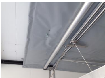
Stange an Lochleiste einhängen und Trennwand an gewünschte Position ziehen.
