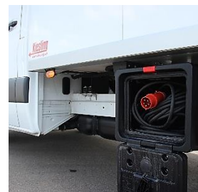
Kabel für Standkühlung seitlich installiert
